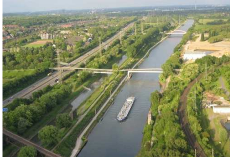
Rhein-Herne-Kanal am Gasometer Foto: Wasser- und Schifffahrtsamt Duisburg-Meiderich
